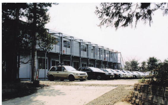
プレハブ棟（内部改修工事中，平成8年）
